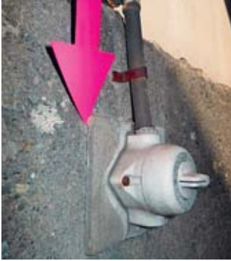
Asbestzementplatten bei Schaltern und Verteilern
