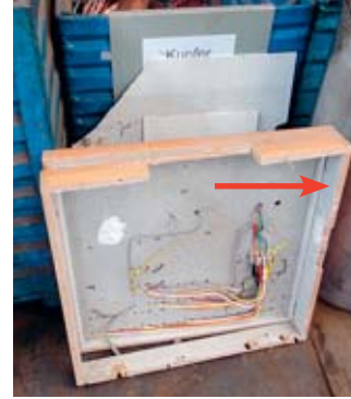
Leichtbauplatten bei Verteilern und Leuchten
