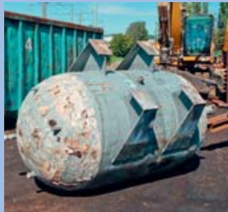
Isolation eines Heizkessels
