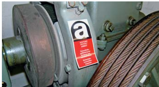
Bremsbeläge an einem alten Liftmotor
