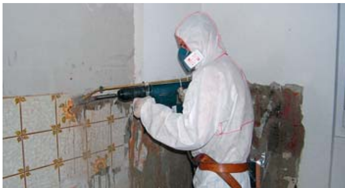
Platten nass entfernen/abschlagen (<5 m 2 )
