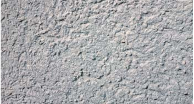
Asbesthaltiger Akustikputz/Abrieb
