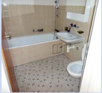
Asbesthaltiger Kleber hinter den Platten
