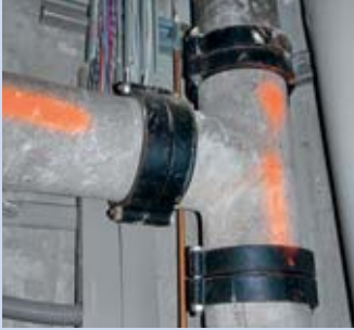
Asbestzement-Rohre
