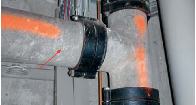
Asbestzementrohr
