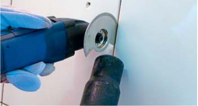
Austausch defekter Platten
