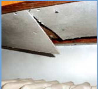
Asbesthaltige Leichtbauplatten
