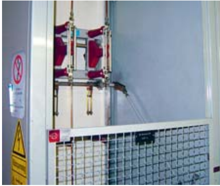
Brandschutzplatte als Trennwand
