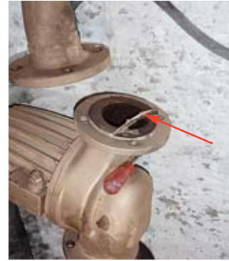
Flanschdichtung
