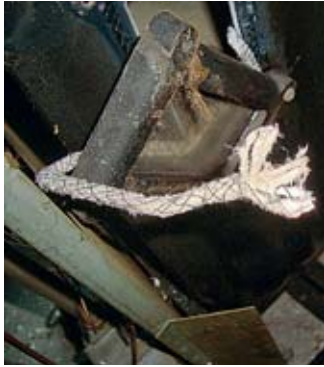
Asbestschnur
