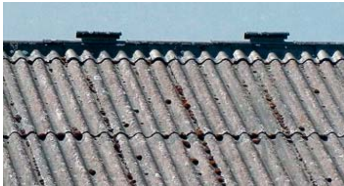
Asbestzementplatten
