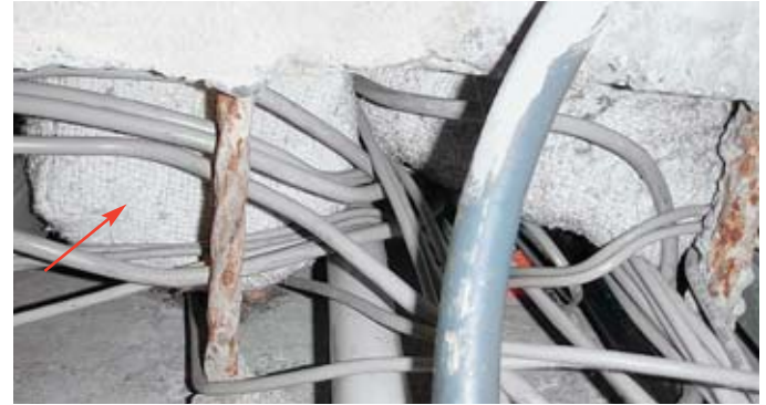
asbesthaltige Brandschutzkissen
