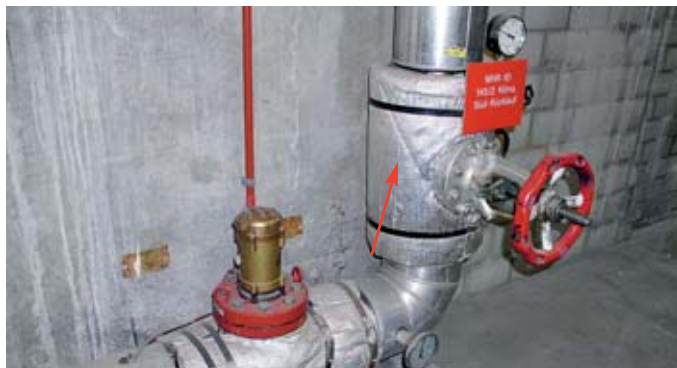
Asbestkissen für die Hitzeisolation
