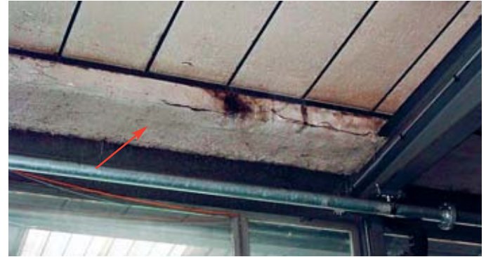
Spritzasbestisolation an Dachkonstruktion
