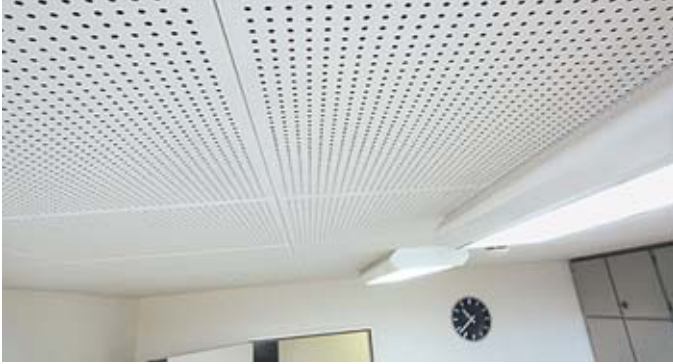
Deckenplatten bei abgehängten Decken
