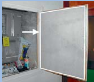
Asbesthaltige Brandschutzplatte
