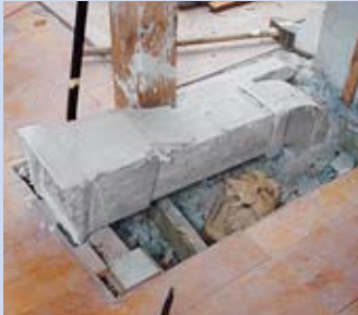
Lüftungskanal aus Asbestzement
