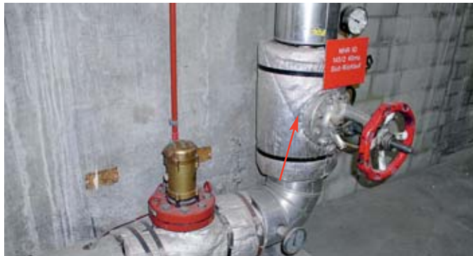
Asbestkissen für die Hitzeisolation
