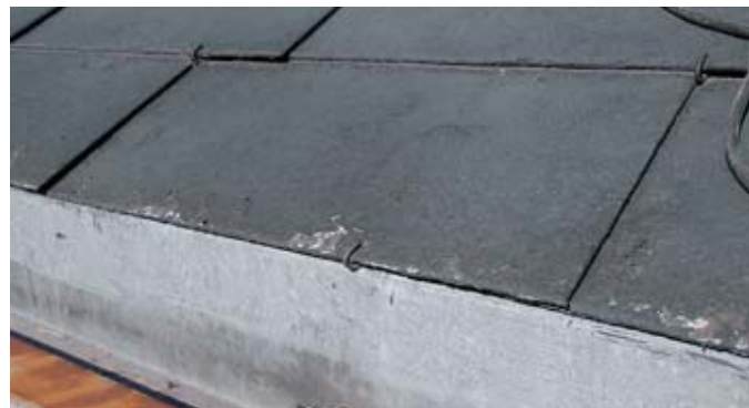
Asbesthaltige Schieferplatten
