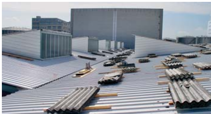
Asbesthaltige Wellplatten
