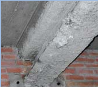
Spritzasbestisolierung
