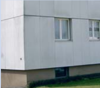
Asbesthaltige Fassadenplatten
