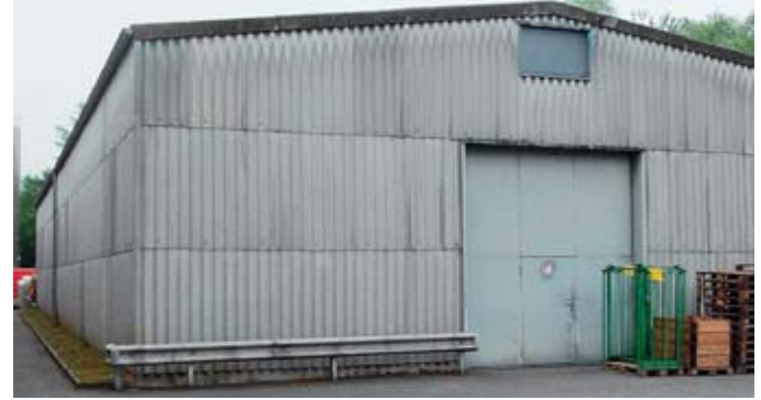
Asbesthaltige Wellplatten
