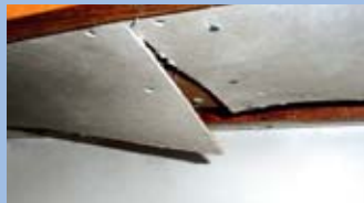
Asbesthaltige Leichtbauplatten
