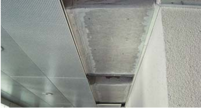
Asbesthaltige Deckenplatten
