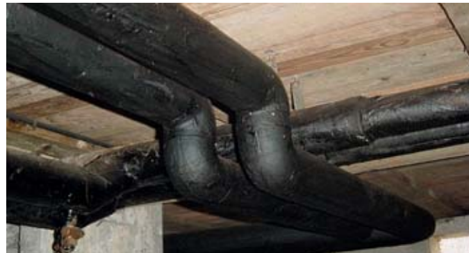
Bitumenbeschichtung
