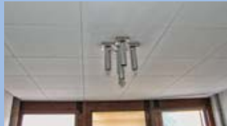
Asbesthaltige Deckenplatten
