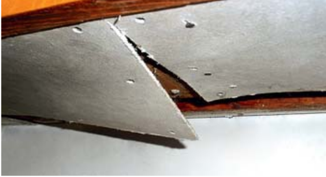
Asbesthaltige Leichtbauplatten
