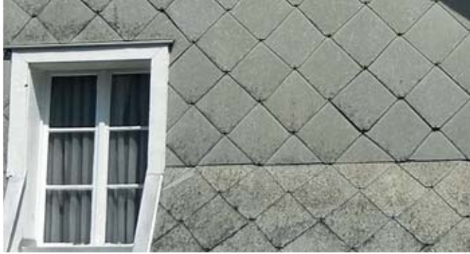
Asbesthaltige Fassadenplatten
