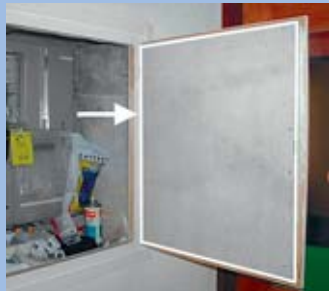
Asbesthaltige Brandschutzplatte
