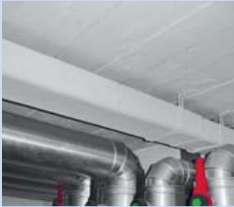
Kabelkanal aus Asbestzement
