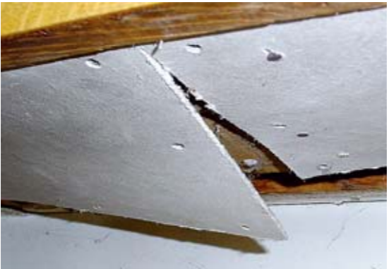
Asbesthaltige Leichtbauplatten
