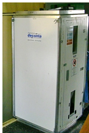
2 Eingang zur Sanierungszone (Schleuse, abgedichtet)
