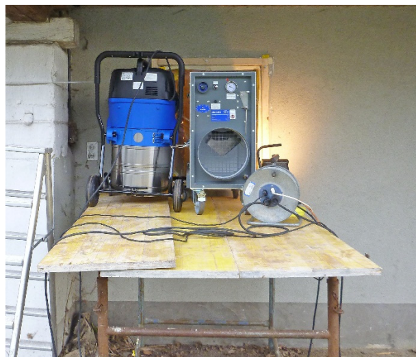
3 Lüftungsaggregat in einem Fenster eingebaut und abgedichtet. Der Schlauch des Staubsaugers wird durch die Abdichtung geführt.
