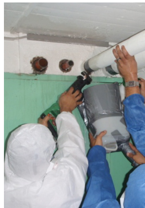
4 Schneiden eines Rohres mit der Fuchsschwanzsäge
