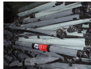
5 Eingepackte Rohrleitungen, bereit für den Transport zum Asbestsanierungsunternehmen
