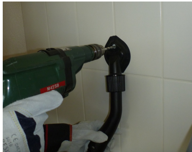
4 Bohrmaschine mit integrierter Absaugung im Einsatz an Keramikplatten mit asbesthaltigem Kleber
