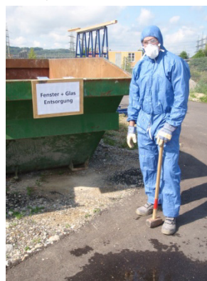
2 Arbeiter mit korrekter persönlicher Schutzausrüstung
