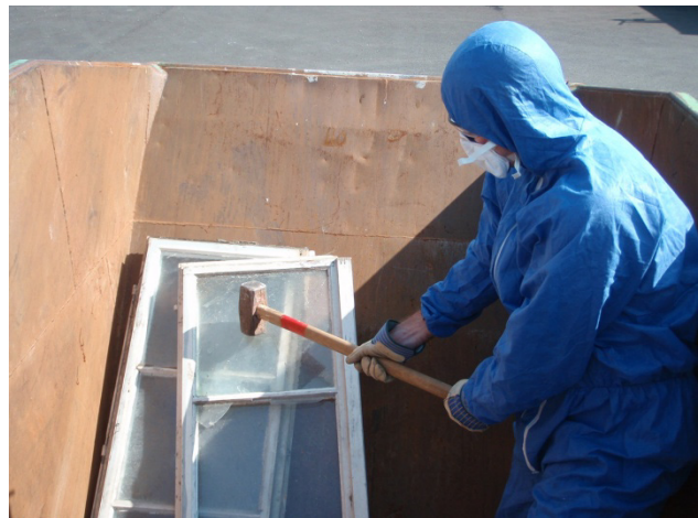
1 Ausglasen mit einem Hammer
