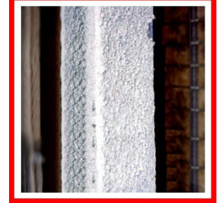
Spritzasbest Brandschutz auf Stahlträger, Decken
