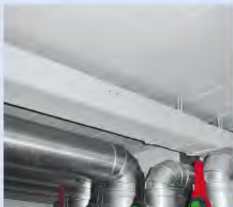
Kabelkanal aus Asbestzement
