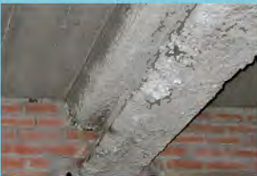
Spritzasbestisolierung
