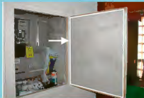
Asbesthaltige Brandschutzplatte
