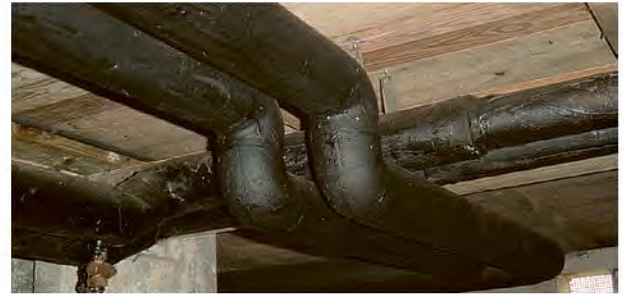
Asbesthaltiger Bitumenanstrich
