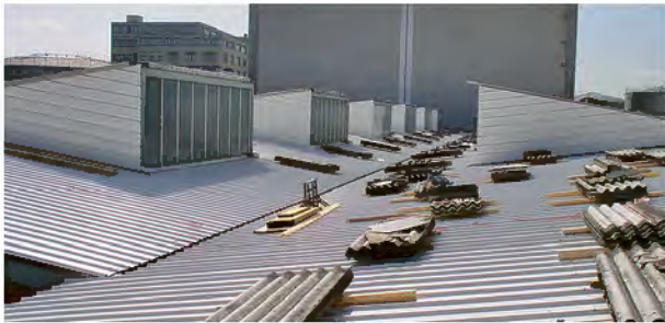
Asbesthaltige Wellplatten
