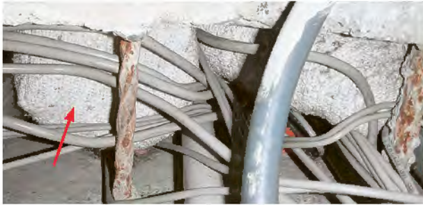
Asbesthaltige Brandschutzkissen
