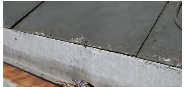
Asbesthaltige Schieferplatten
