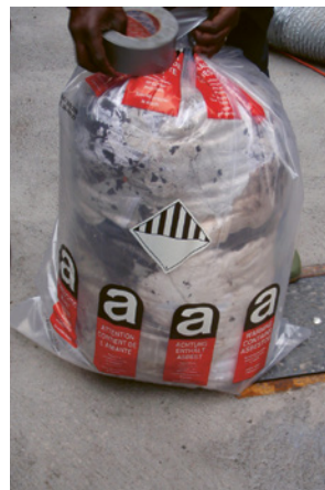
6 Kunststoffsack mit der Kennzeichnung «Asbest»
