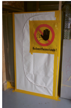
4 Dieser Sanierungsbereich ist räumlich sauber abgetrennt und gekennzeichnet.
