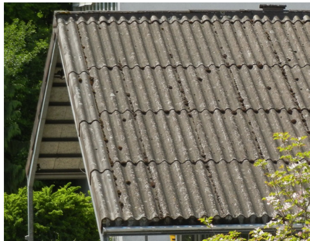
1 Wellplatten aus asbesthaltigem Faserzement
