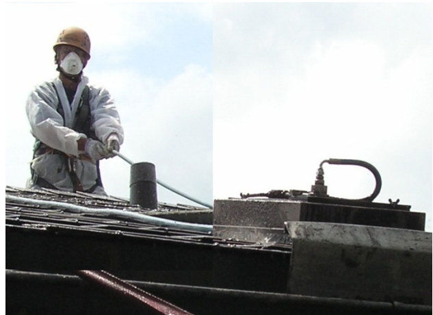
4 Asbestflächen-Reinigungssystem mit geregelter Wasserkreislauf
