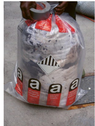
4 Kunststoffsack mit der Kennzeichnung Asbest
